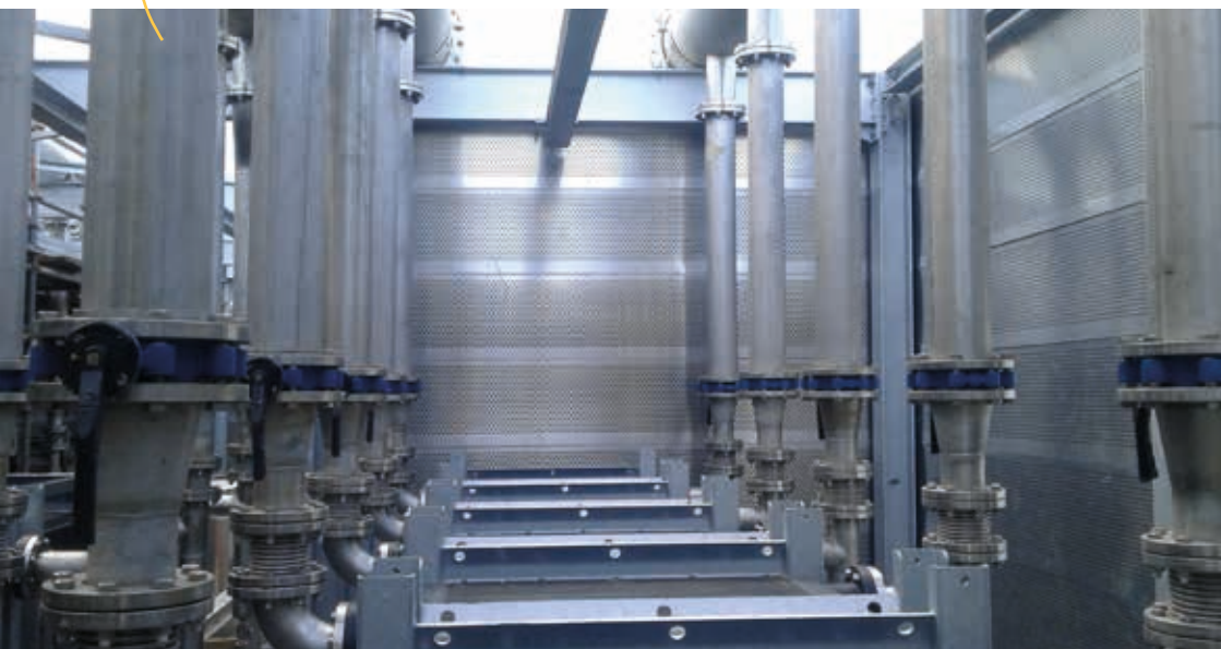
AKOESTISCHE ABSORPTIEPANELEN BIJ VENTILATORE
